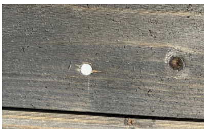
FIG. Spiker- eller skruehode bør ligge i flukt med treoverflaten, som vist til høyre. Foto: Holzforschung Austria
