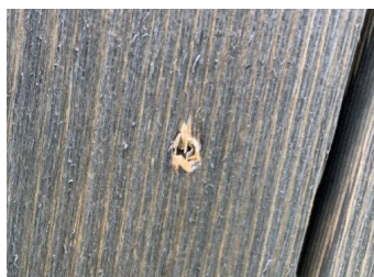
FIG. Spiker- eller skruehode bør ligge i flukt med treoverflaten, som vist til høyre. Foto: Holzforschung Austria
