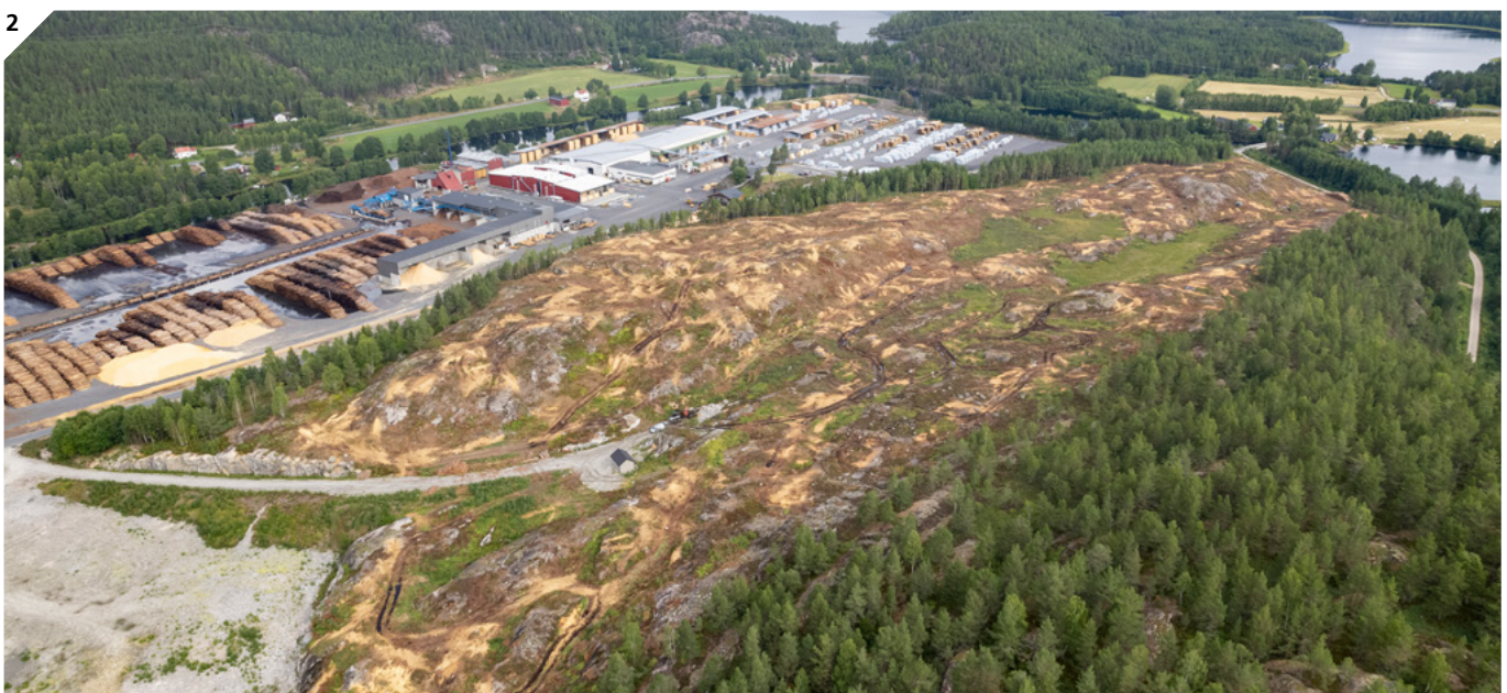
1. Bygging av et flerfunksjonelt behandlingsanlegg for impregnering og modifisering av tre på avdeling Skarnes. Anlegget gir muligheter for å lansere nye, holdbare og banebrytende produkter uten bruk av biocider.
